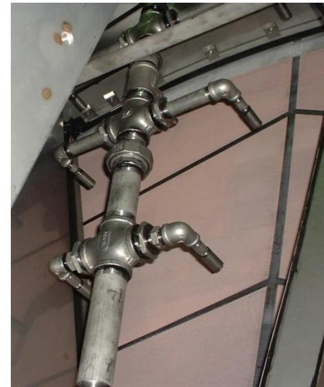
Система очистки горячей водой
