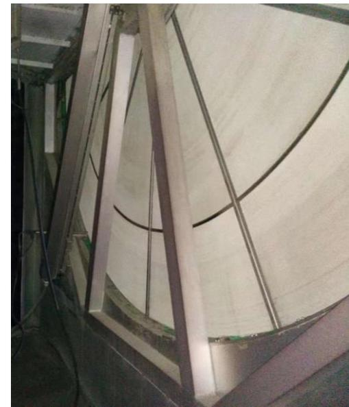
Одним из приоритетных направлений производственной политики любого предприятия является энергосбережение. Секция рекуперации тепла, смонтированная в вентиляционной установке TICA, отлично справляется с этой задачей. Благодаря ей поступающий свежий воздух доводится до температуры, близкой к температуре возвратного воздуха.
