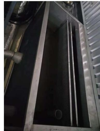
По желанию заказчика вентиляционная установка может оснащаться секцией увлажнителя воздуха (вода распыляется естественным образом либо под высоким давлением).
