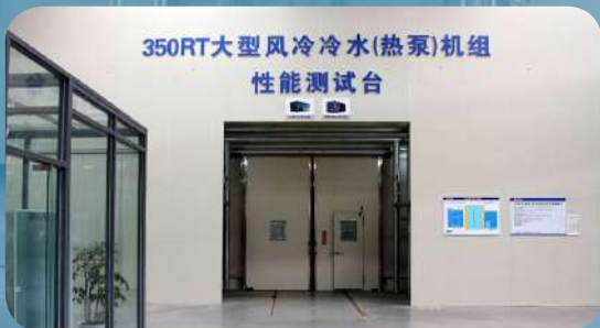
Лаборатория для проведения испытаний воздухоохлаждаемых чиллеров производительностью до 350 RT (1230 кВт)
