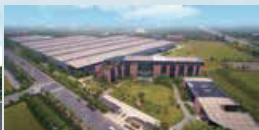
Производственная база и штаб-квартира в Нанкине
