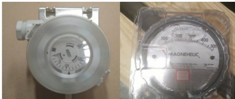
Реле дифференциального давления
