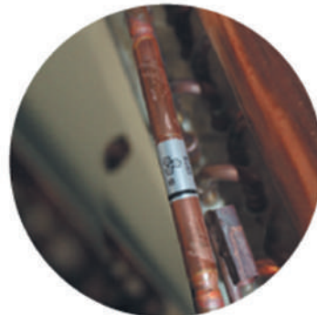
Обратный клапан в нижней части chillера
