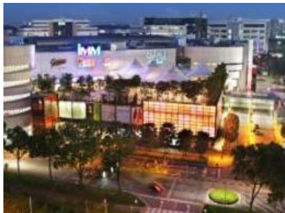
Торговый центр IMM Mall (Сингапур)
