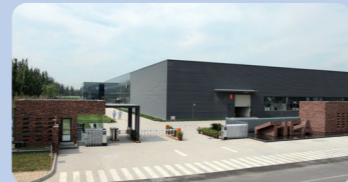
Производственная база в Тяньцзине
